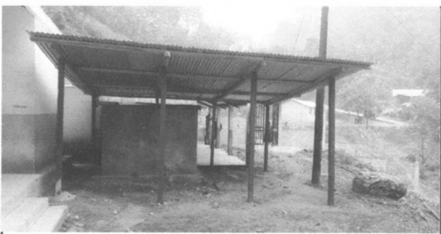
Foto 5: CAMBIO DE TECHO DE ALJIBE
